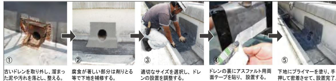
塩ビシート防水の場合 ※サイズの選び方: 例 / ピッタ蒙を使って排水管内径を測ってφ70の場合、φ70を選ぶ。
