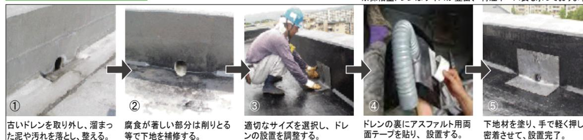
ウレタン防水の場合 (ヨコ型) ※サイズの選び方: 例 / ピッタ蒙を使って排水管内径を測ってφ70の場合、φ70を選ぶ。
