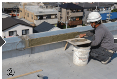
② 塩ビドレンをフィットさせるために、下地を補修する。
