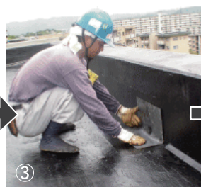
③ 適切なサイズを選択し、ドレンの設置を調整する。
