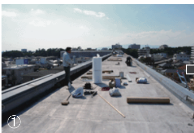
① 古いドレンを取り外し、溜まった泥や汚れを落とし、整える。
