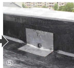
⑤ 下地材を塗り、手で軽く押して密着させて、設置完了。
