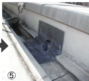
⑤ 下地にプライマーを塗り、手で押して密着させて、設置完了。
