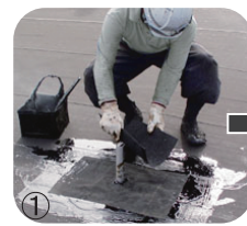
① アスファルト工法の場合はパッチワークする。
