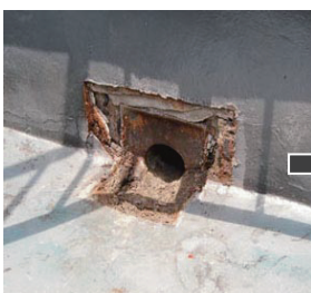
古いドレンを取り外し、溜まった泥や汚れを落とし、整える。
