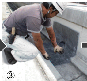
③ 適切なサイズを選択し、ドレンの設置を調整する。
