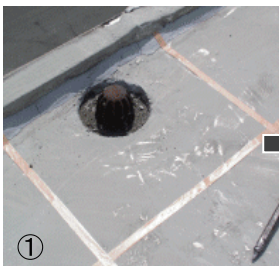
① 古いドレンを取り外し、溜まった泥や汚れを落とし、整える。
