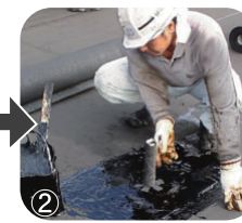
② 筒巻作業をしてキャップを差し込んで完成。
