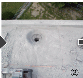
② 腐食が著しい部分は削りとり等で下地を補修する。
