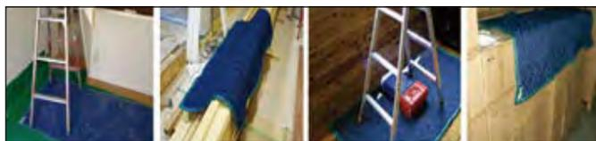
床の傷付き防止 汚れ防止 道具の仮置き 埃付着防止
